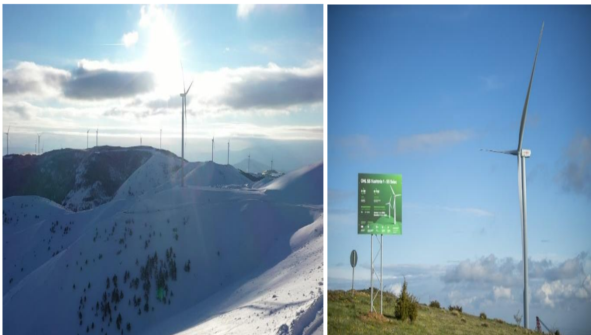
Abbildung 6: Beispiele von bereits bestehenden Erneuerbare-Energien-Projekten
